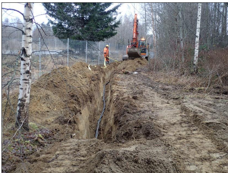
Valvonnassa kaivetun kaapeliojan täyttämistä. Länsilounaaseen.
