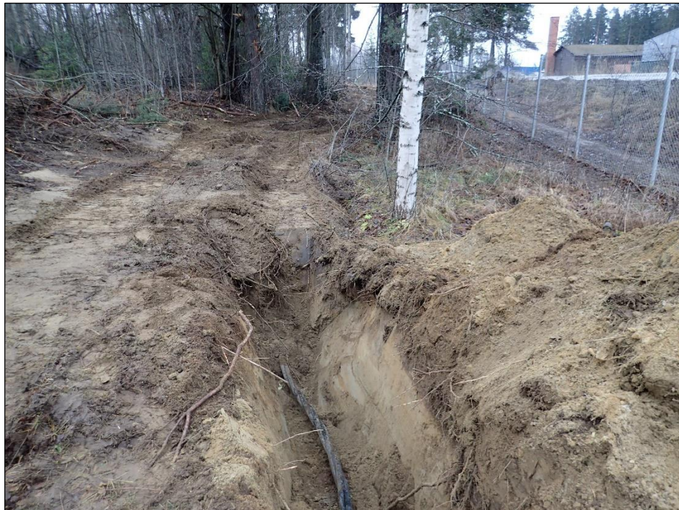
Tilanne paikalla valvonnan alkaessa. Kaapeliojaa oli jo kaivettu ja peitetty osittain siltä alueelta, mikä oli tarkoitus kaivaa valvonnan aikana. Itäkoilliseen.
